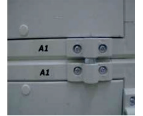
Resim 3. Hücre birleştirme
